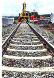
An der neuen Birkenbringhäuser Haltestelle sind die Arbeiten noch in vollem Gange.
