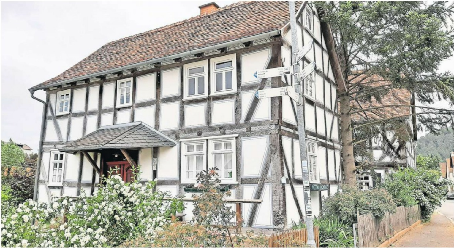
Über Fördermittel, die über die Region Burgwald-Ederbergland beantragt wurden, wurde zum Beispiel die Fassade des Nebengebäudes des Dorfmuseums Oberrospehe ertüchtigt.
